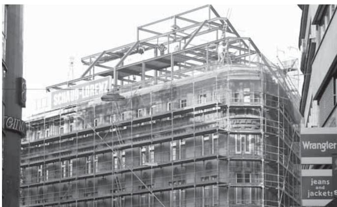
Wiederaufbau des Daches und Fassadenrenovierung (1980-1982)
