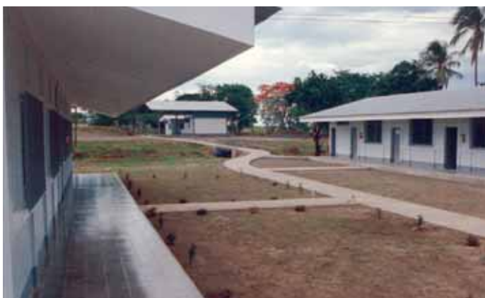
Die Ausbildungsgebäude kurz vor Fertigstellung
